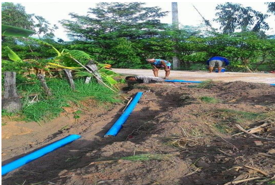
โครงการวางท่อน้ำประปา
